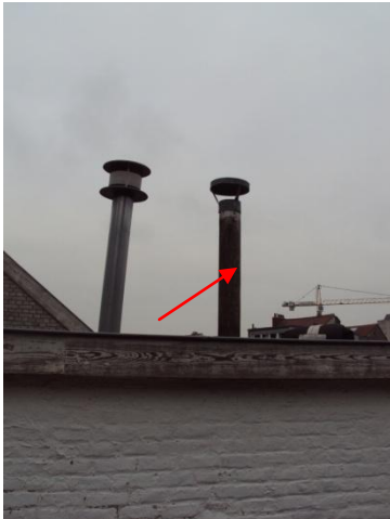
Photo 1 Arrière cours, toit, tuyaux
