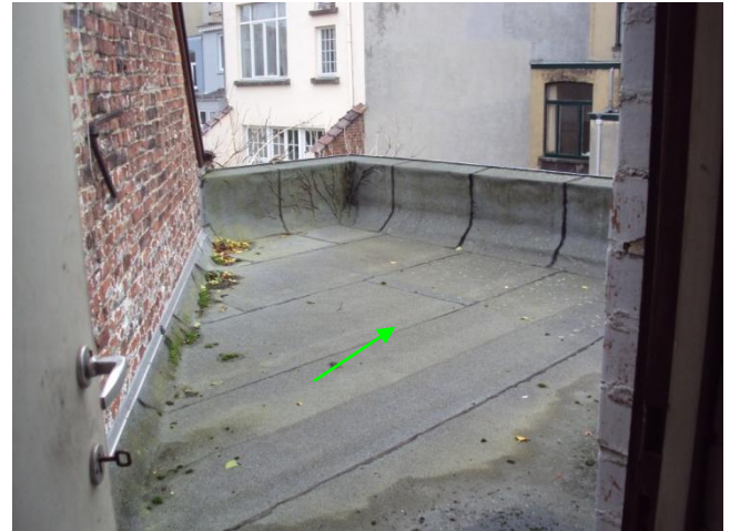
Photo 2 Arrière cours, toit, roofing
