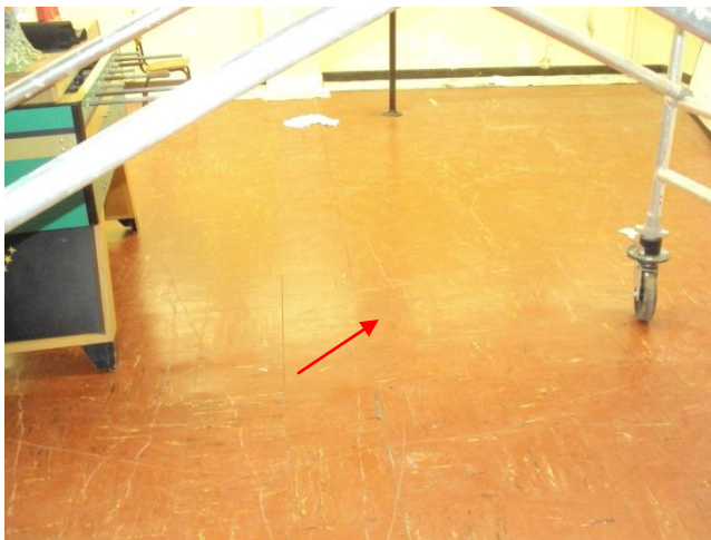
Photo 3 Garderie, revêtement de sol de type « Floorflex »
