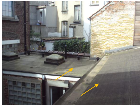
Photo 2 Anciens vestiaires et cuisine, roofing
