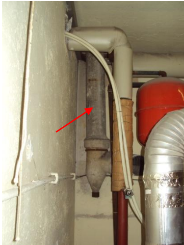
Photo 1 Conciergerie, cave, conduite fibrociment
