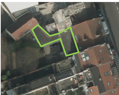
Photo 5 Toiture annexe, roofing
