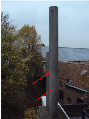
Photo 1 Toiture annexe, tuyaux
