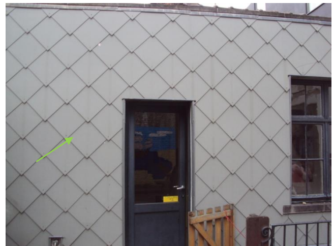
Photo 4 Cours, murs annexes, bardage
