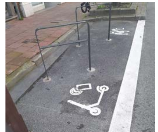
Dropzones installées en voirie régionale.
