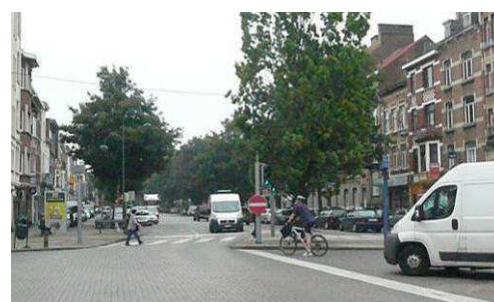
Berme centrale à élargir afin de favoriser les traversées cyclistes et piétonnes
