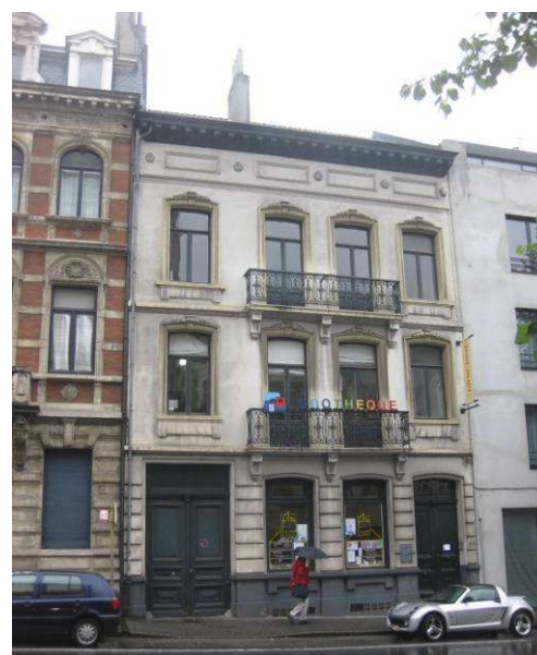
Vue depuis la chaussée d'Auderghem
