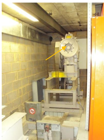
Photo 3 Zone administrative, machinerie d'ascenseur
