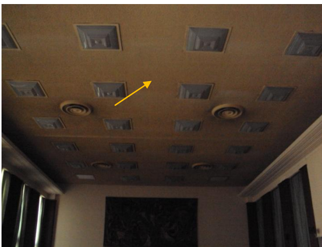
Photo 7 Salle d'apparat, plafond
