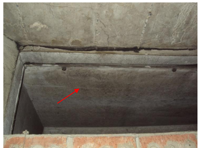
Photo 8 Zone administrative, machinerie, conduit
